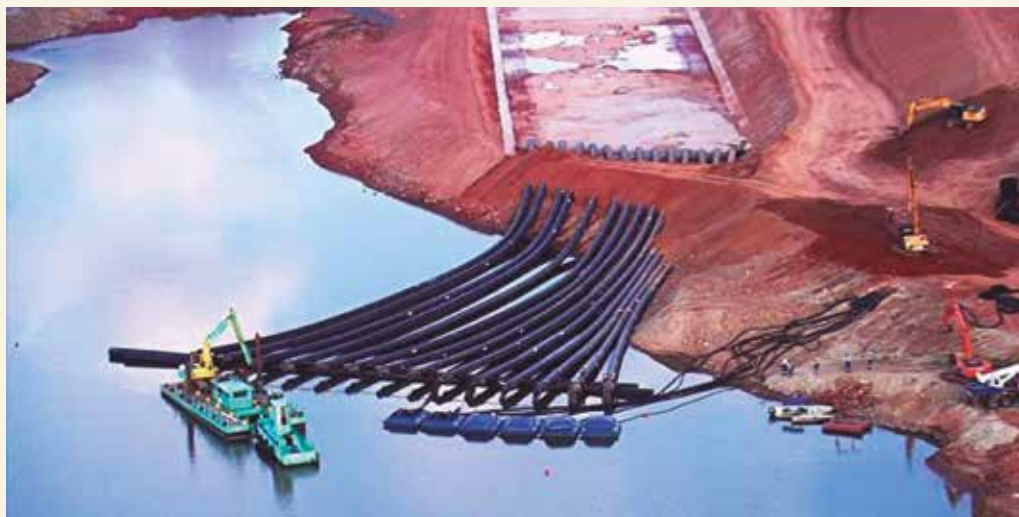
Figura 37. Instalação de equipamentos para retirada de água da primeira cota do volume morto no Sistema Cantareira, em maio/2014.
